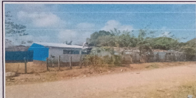
Foto 3: Entecho del Modulo 3.
