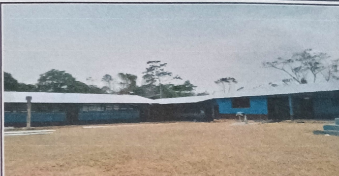
Foto 2: Entecho del Modulo3
