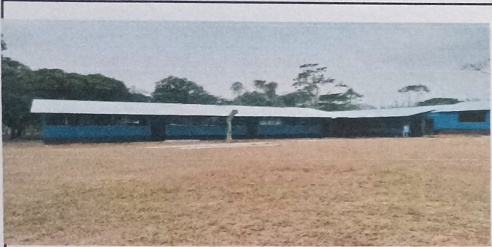
Foto 1: Entecho del Modulo1
